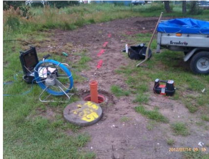
TV-inspektion af kloak
